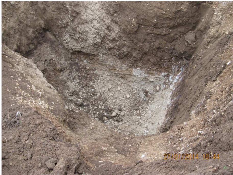
Fig. 4: lo scavo n. 1 e la ghiaia del fondo scavo
